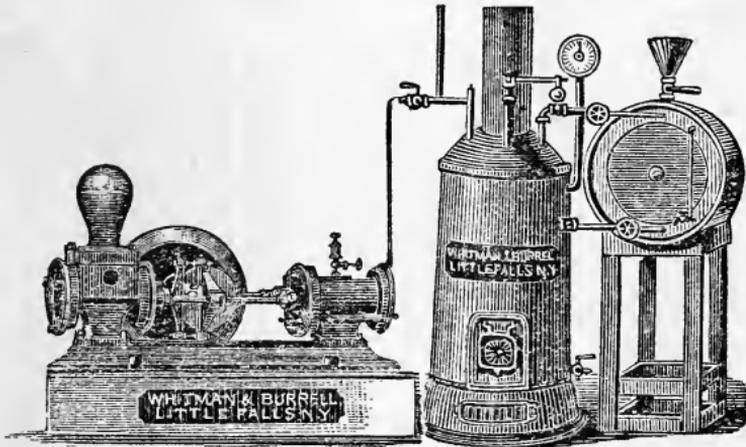
Fig. 107.—WHITMAN & BURRELL'S STEAM ENGINE AND PUMP.
